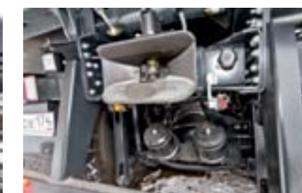
Сзади — сцепка Rockinger, энергоаккумуляторы на мостах расположены удачно
