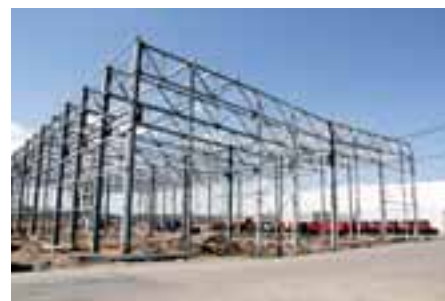
Строительство автосборочного цеха № 3
