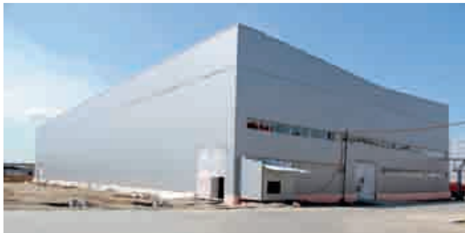
Ведется строительство нового корпуса сборки кабин. В нем будет полностью осуществляться сборка, грунтовка и окраска кабин для автомобилей IVECO-АМТ
